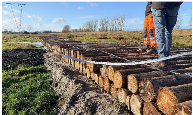
Der Knüppeldamm wird gebaut. (Foto: J.Limberg, LGMV, 2025)
