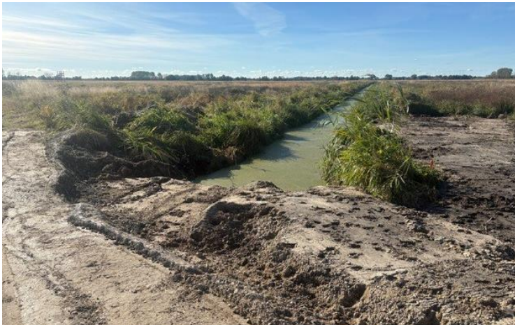
Abtragung von Verwallungen an den Gräben. (Foto: J.Limberg, LGMV, 2025)
